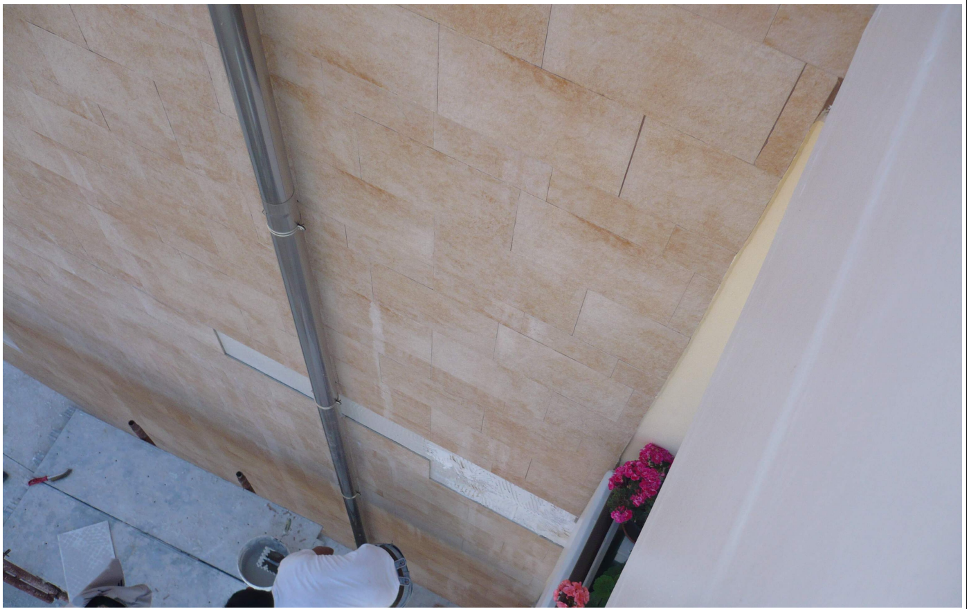
Fig. 2: Parete di tamponamento Ovest durante il ripristino del rivestimento.
